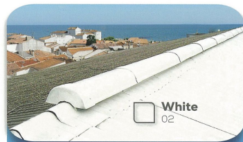
Atap Asbes & Kayu
